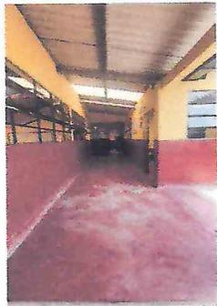
**FOTO NO. 3 NIVELACION DE PISO DE PASILLO A NIVEL DE AULAS PARA QUE NO QUEDEN GRADAS**
